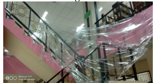
Gambar 8. Kondisi ruang koleksi setelah ditutup dengan plastik
